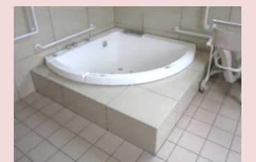
ジャグジー浴槽
